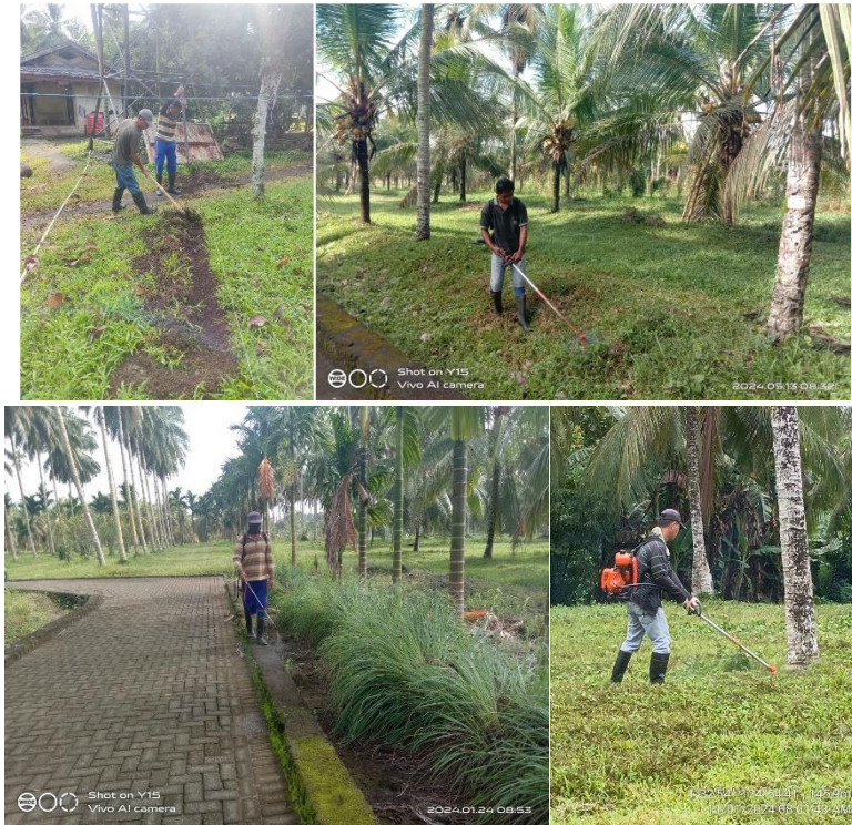
Gambar 65. Pembersihan jalan dan saluran air
