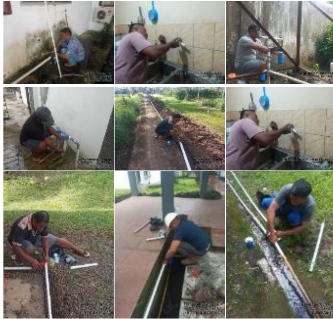
Gambar 39. Pemeliharaan instalasi air
